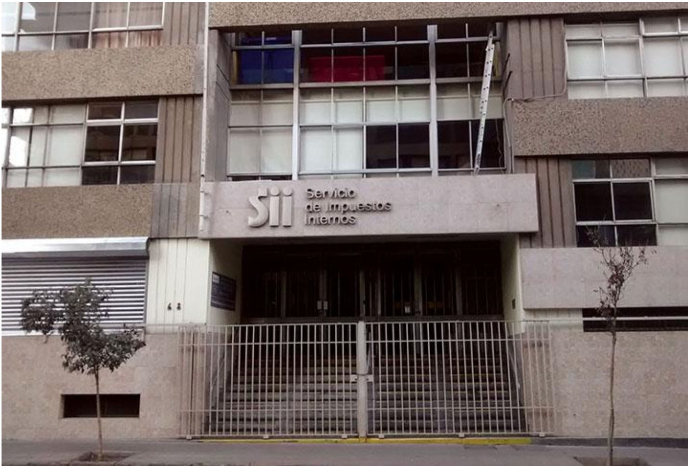
Servicio de Impuestos Internos building (Warko | CC by-SA 4.0 | Wikimedia Commons)
